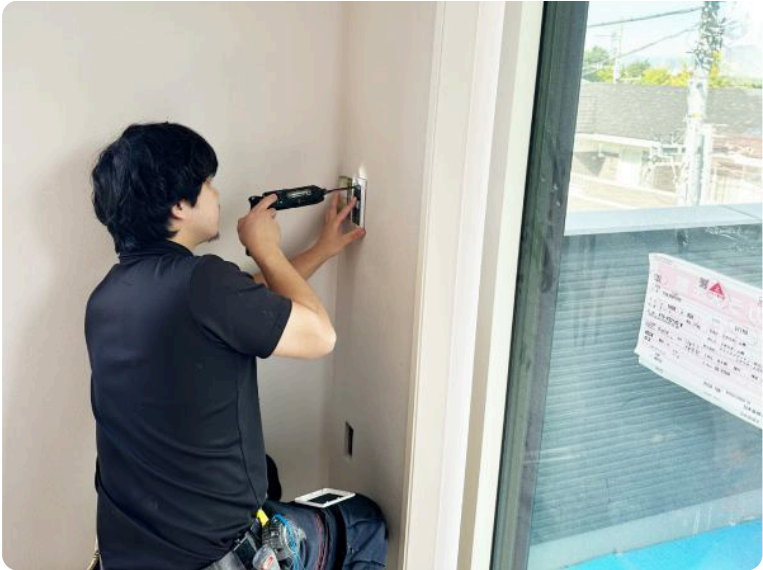
こんな風に、室内で作業することもあります。「建設＝外仕事」とイメージする方は多いですが、意外と雨や風の影響を受けにくい仕事です。
